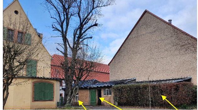
Seitenansicht von Garage, Schuppen und Schauer (hinter der Hecke)
